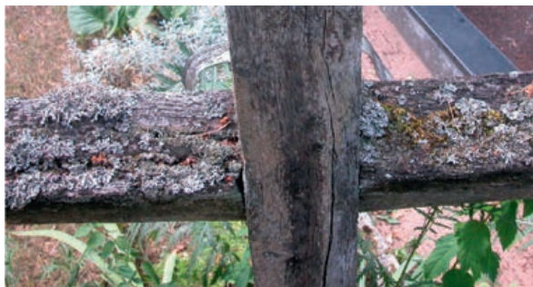
Fot. 4. Porosty na drewnianym krzyżu
