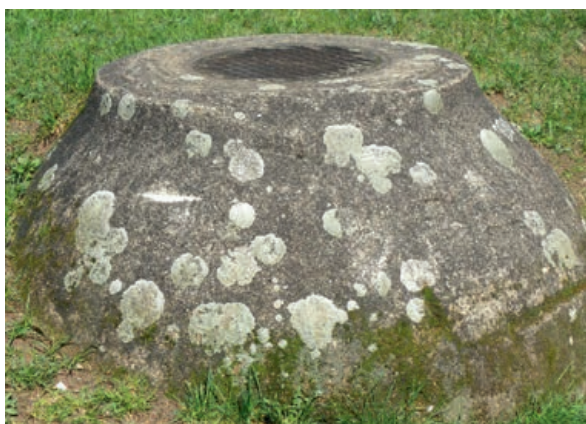
Fot. 6. Mozaika porostów na betonie
